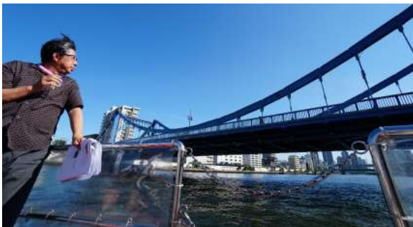
写真 - 3 隅田川の清洲橋は、日本で初めてニューマチックゲートン基礎を用いた吊橋
