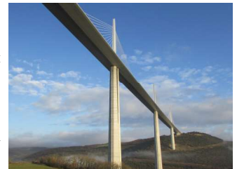
海外橋梁視察ミヨ一高架橋
