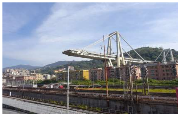
写真-7 倒壊したポルチェベラ橋
