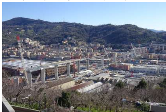
写真-8 復旧の進むポルチェベラ橋
